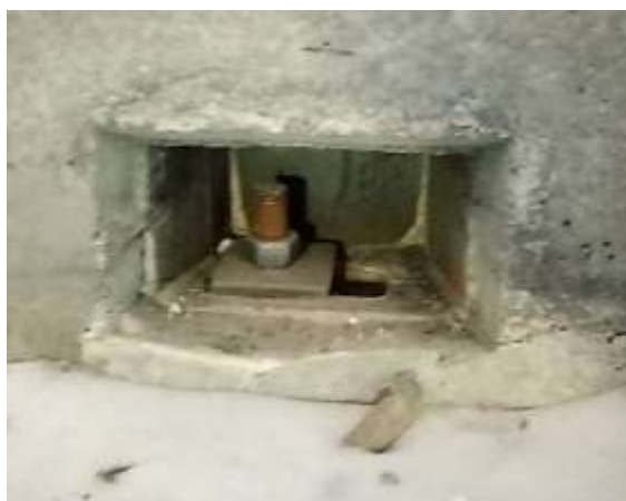
б – болтовое соединение
